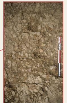
Traces d'une machine à scier à lames multiples dans le sol de béton
